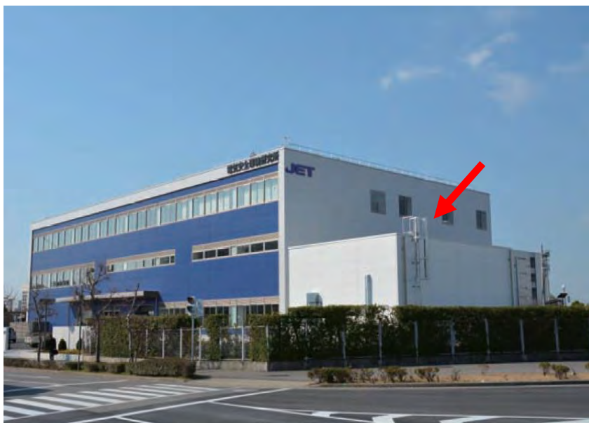
JET 関西事業所 蓄電池評価試験棟 * セル及び小型モジュール試験を実施
