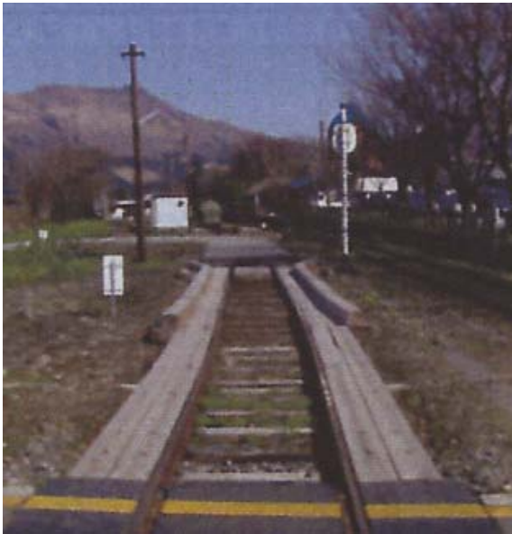
写真 13 モードインターチェンジ部(南阿蘇鉄道)
