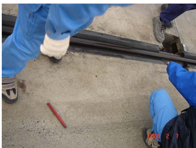
写真10 車両走行後の異物排障例
