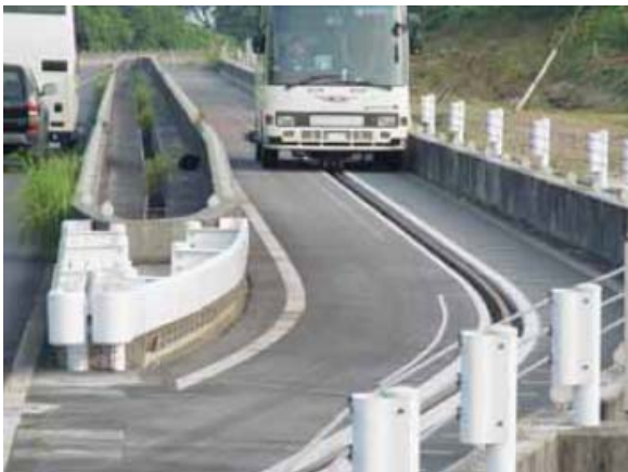
写真7 軌道内に埋め込まれた逸脱防止レール
