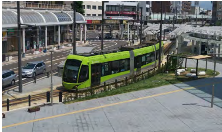
実際に完成した福井駅前電停の状況
