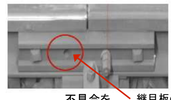
締結装置の外れ
