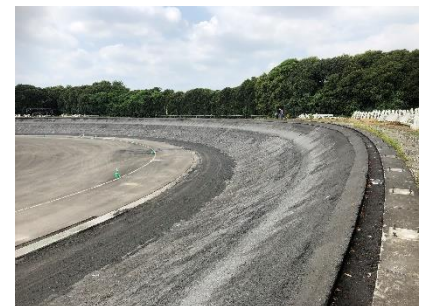
走行試験路の改修
