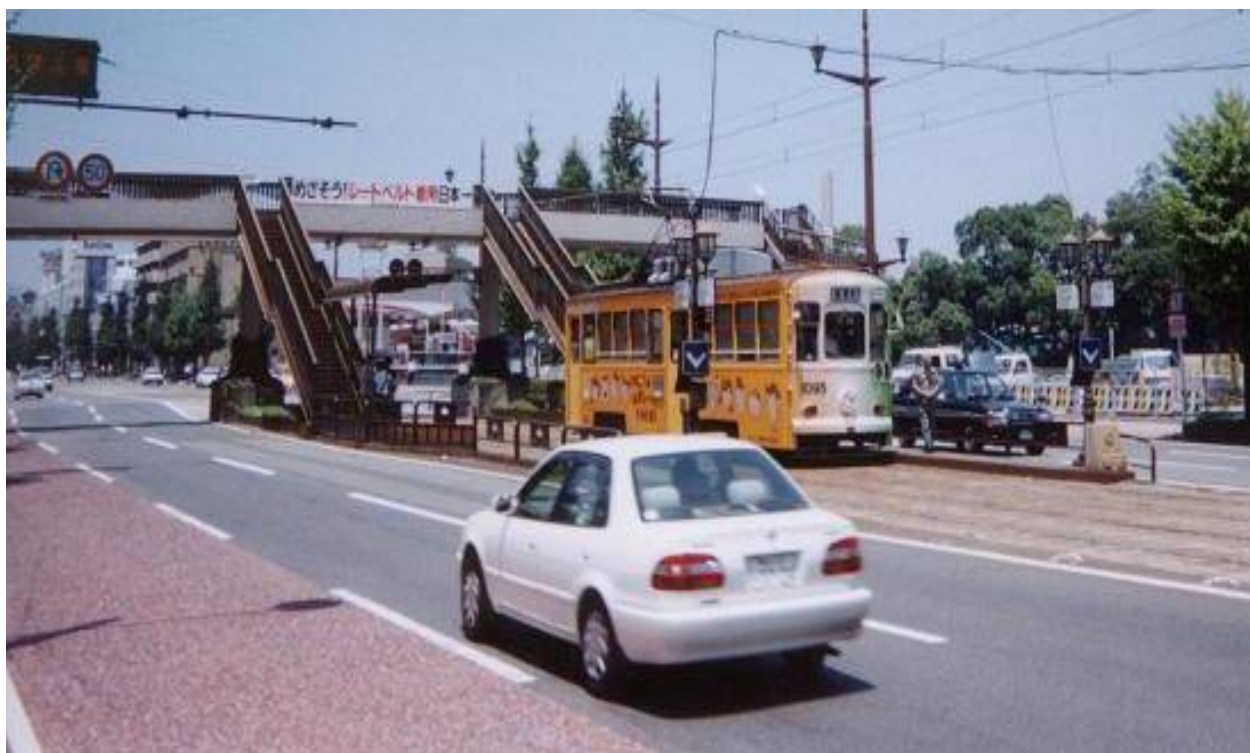
停留所への移動手段が歩道橋より他にない例
