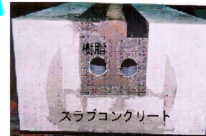
レールの周りを樹脂で覆い、振動低減化
