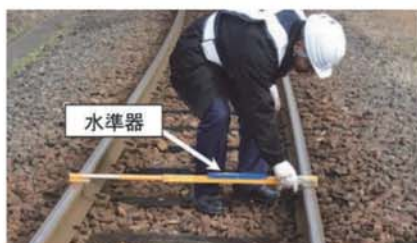
図3 静的水準変位検測の様子
