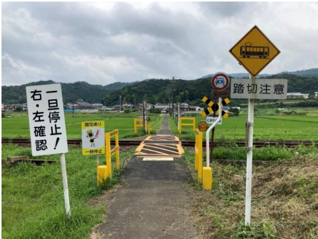
< 応急対策後の踏切 >
