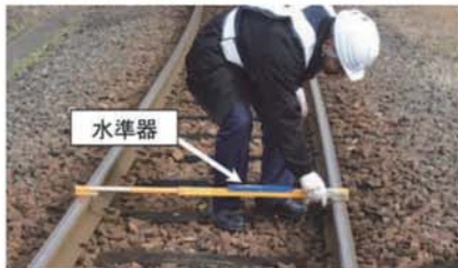
図3 静的水準変位検測の様子
