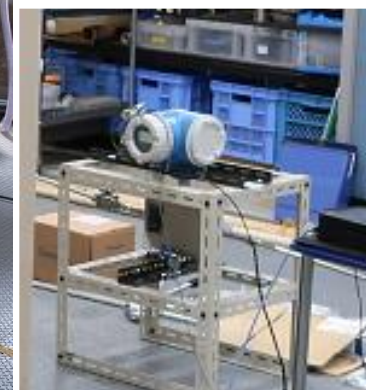
コリオリ式流量計 設置状況
