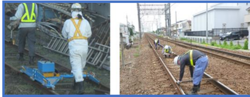
簡易軌道検測装置
