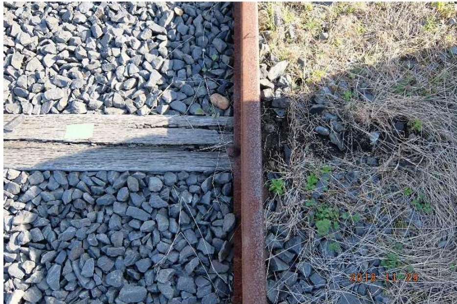
木まくらぎ不良の例(割れ) (交通研フォーラム2019より)
