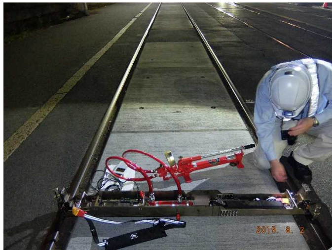
地点1(施工後すぐの軌道)
