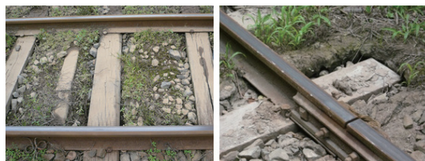
a) 線路中 b) レール継ぎ目
