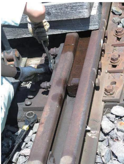
図7 ヒールボルトの締結状況
