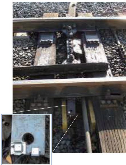
図4 センサの取付け状況
