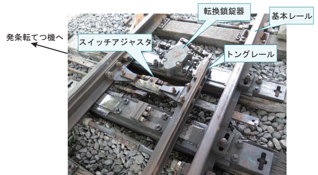
図2 転てつ機主要部分の構造
