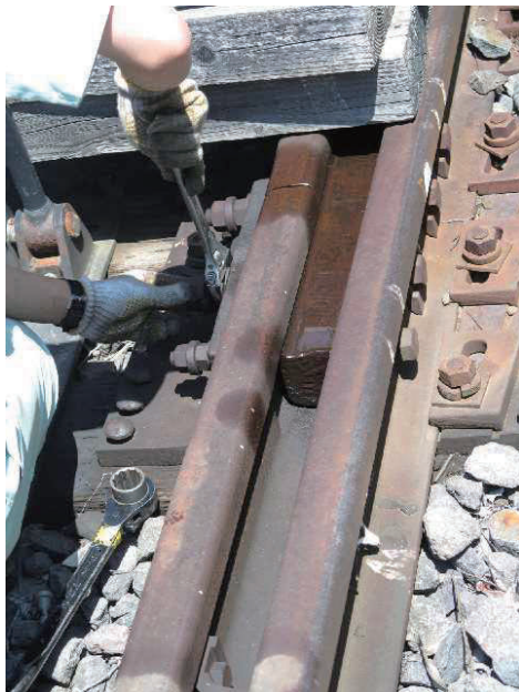
図7 ヒールボルトの締結状況
