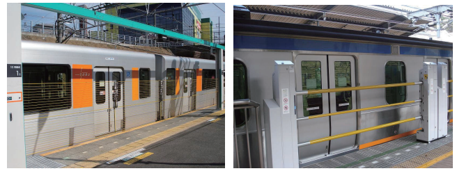
図 4 昇降式ホームドアの試作例（左：ロープ式 右：バー式）
