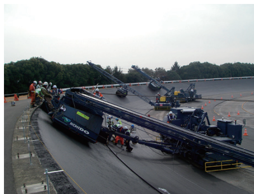
図3 走行路試験路大R部の改修工事
