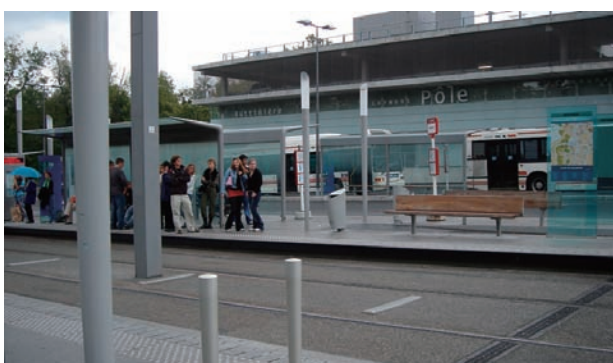
図7 駐車場とバス停が集約された電停（ポルダー）
