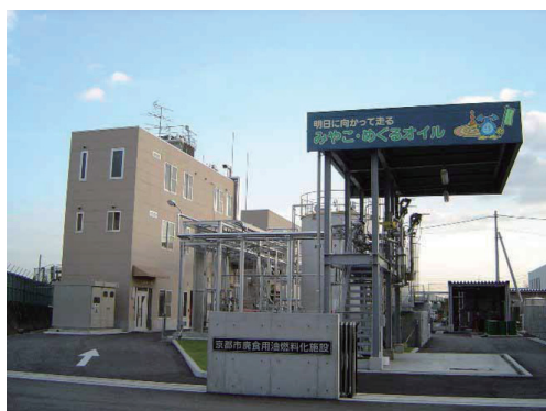
図1 京都市廃食用油燃料化施設
