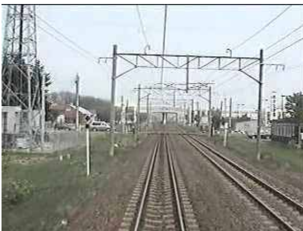
図4 受信障害地点周囲状況例
