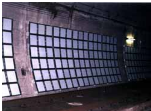
図1 トンネル吸音板の設置
