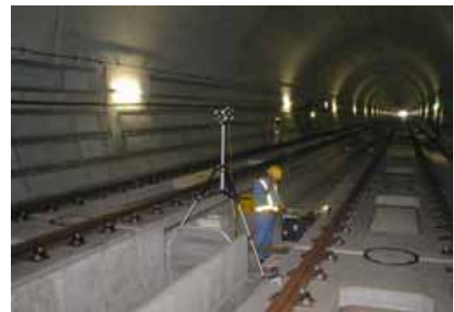
図3 吸音板とスピーカー試験
