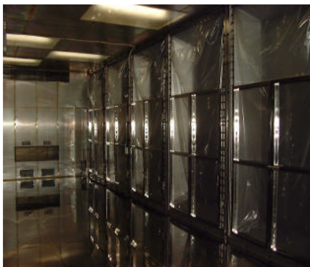
図 4 テドラシートを採用した SHED 室内部
