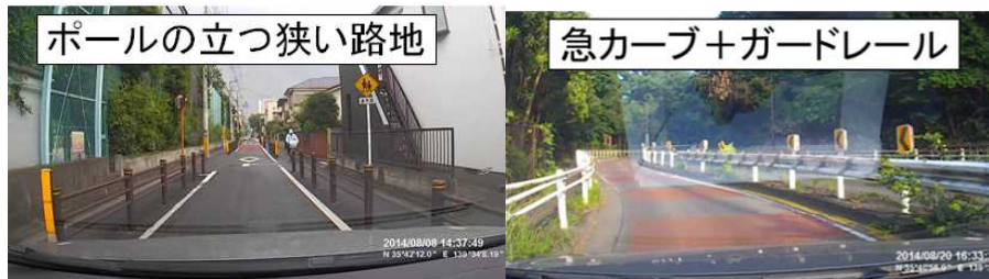
走行した道路状況の例
