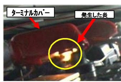
ターミナルカバー バッテリーの誤った取り付け による火災
