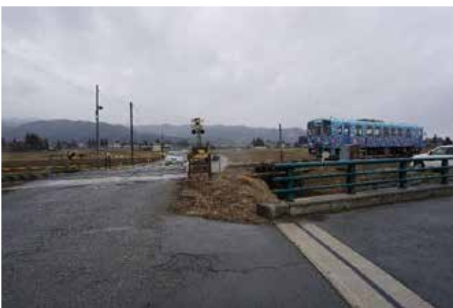
図4 実列車走行実験の状況
