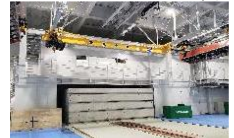
バリヤブロック・制御室
