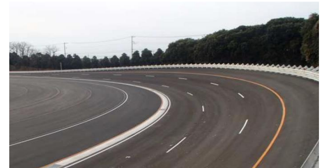
走行試験路の改修
