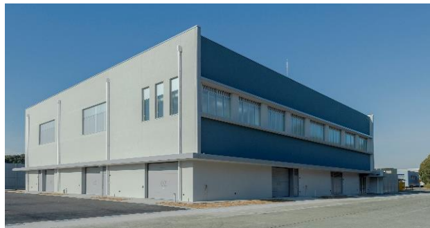
WLTP試験に対応した試験施設
